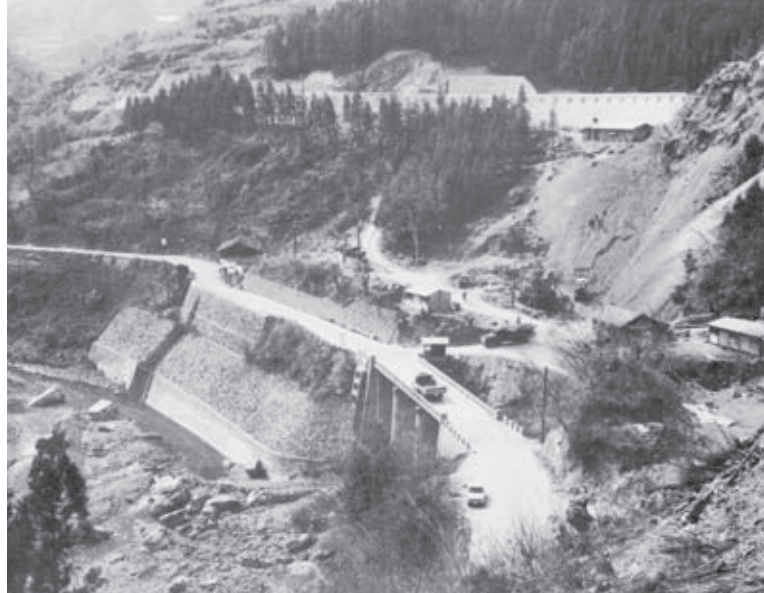
工事風景 法久八壺橋付近の旧県道(下)と新県道(上)
