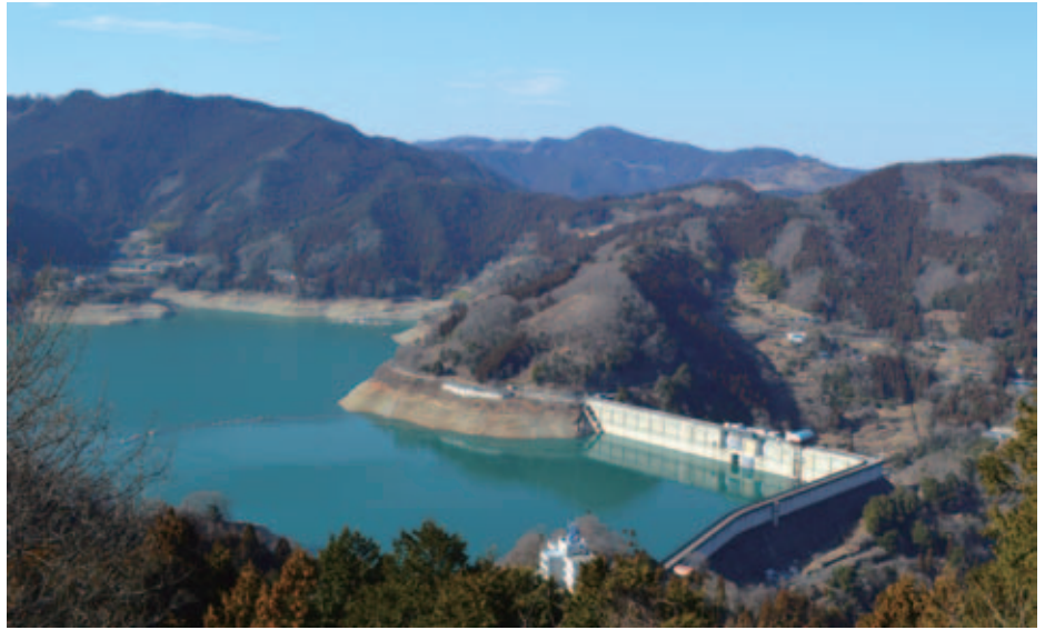
神流湖 手前の白い建物が下久保ダム管理所 対岸の山々の電波塔と結び、水量等のデータを収集している。
