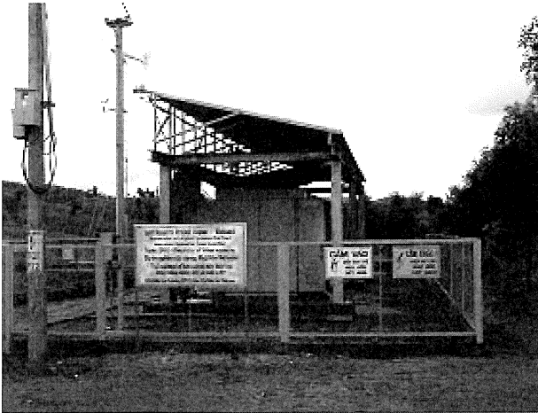
システム外観 (System View)
