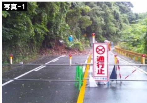
▲長門市俵山 (H25.9 被災状況)
