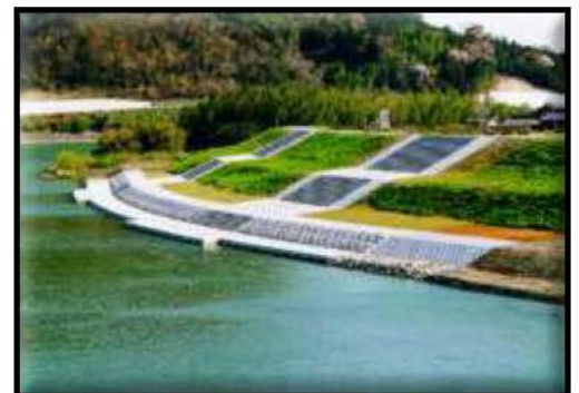
榊田川合流部 (船着き場を兼ねた護岸)
