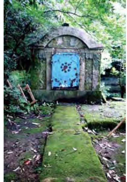
写真 16 轟泉水道取入口
