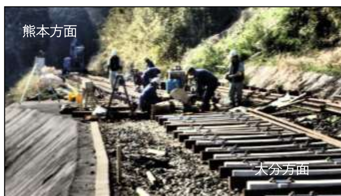
立野駅～赤水駅間 レールの敷設作業の様子
