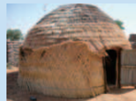
アンドロポゴン等で建てられた家屋
