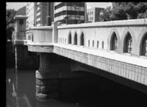
橋の構造はラーメン橋台橋。食べるラーメンのことはない。震災復興橋梁デザインにより美しく甦った。
