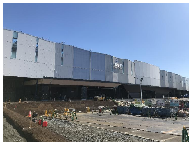
△ 高架駅化する愛宕駅（施工中）
