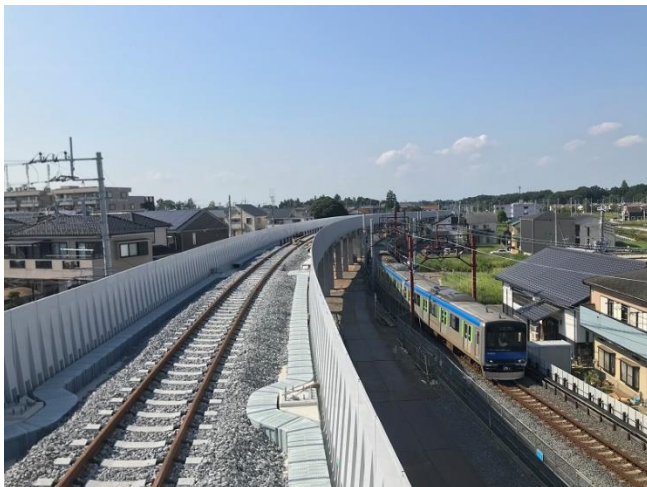
△ 愛宕駅付近の高架橋（施工中）
