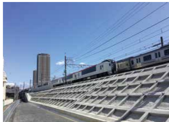
盛土耐震補強
