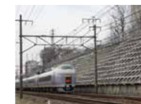
切取りり面工(吹付砕工)
