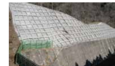
自然斜面防護工(吹付砕工)
