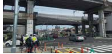
連続立体交差化に伴い開通した都市計画道路
