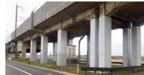
耐震補強対策
