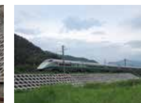
盛土のり面工(吹付砕工)
