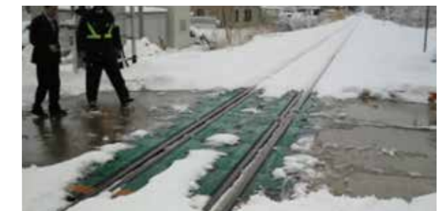
降雪地帯で交通量が多い踏切等に対してロードヒーティング等を整備
