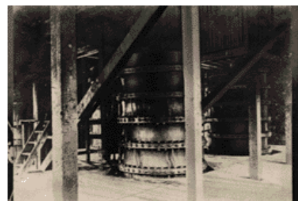
第4図 日本初のせいろ型の木釜 明治22年(1889)遠州、気田(現静岡県春野町)に設けられた 「紙の博物館蔵」
