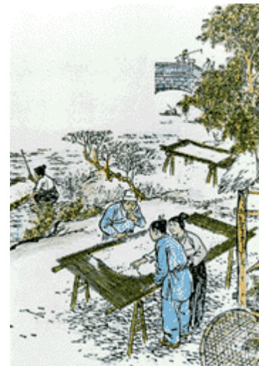
古真綿(絮)を水の中で叩き、取り上げ、箕の子の上に紙の層が出来ているのを取り上げている(造紙史話編写組編造紙史話より)
