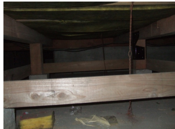
写真 6.3.1 ベタ基礎+在来軸組構法による1階床下の状況例
