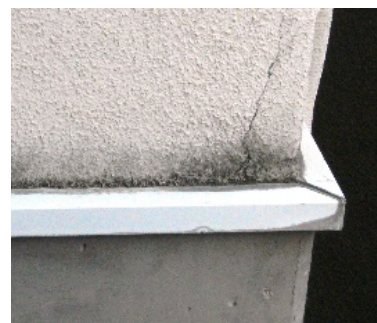
外壁と下端水切りの取合いが湿潤している状態
