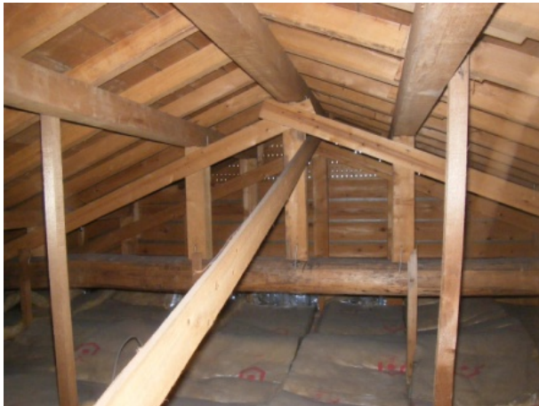
写真 6.3.7 点検口から覗いた小屋裏の様子
