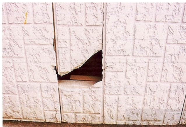
写真 6.3.6 サイディングの欠損
