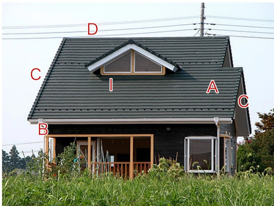
写真 3.1.5 プレスセメント瓦の部位説明
