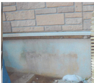
外張基礎断熱の側面の汚損状態
