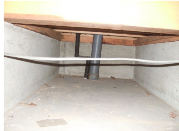
写真 6.3.4 1階床下配管の様子
