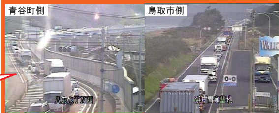
【写真②】追突事故による通行止め状況 (鳥取市気高町八束水地内 H18年11月)
