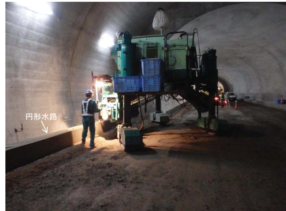
(写真)スリップフォーム工法による円形水路施工状況
