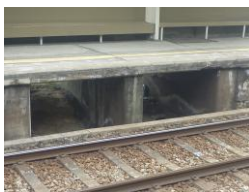
東垂水駅ホーム下待避スペース
