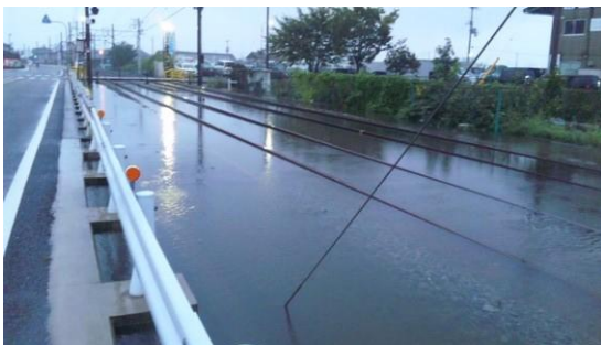
台風12号により冠水した線路
