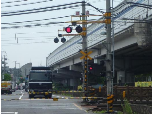
天井川東踏切道
