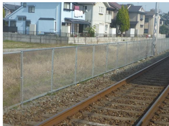
立入防止柵の設置
