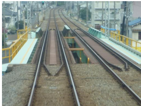
福田川橋梁および大坪架道橋まくらぎ更新
