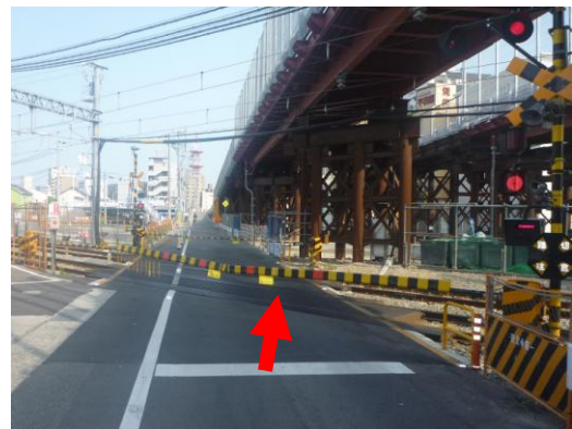
国道東踏切道に設置した大口径遮断棒
