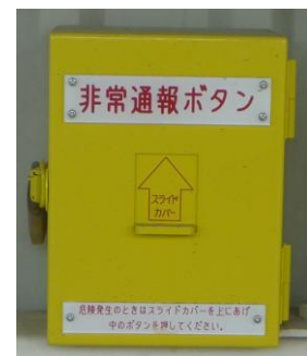
ホームの非常通報ボタン
