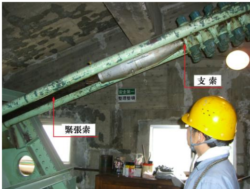
普通索道（ロープウェイ）支索・緊張索移動量の点検
