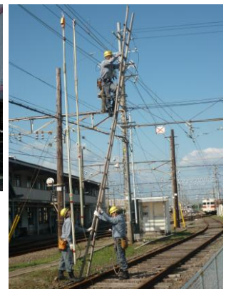
架線復旧作業
