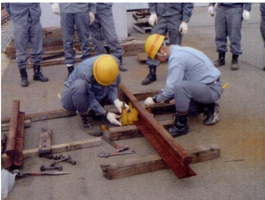
レール折損時の応急処置訓練
