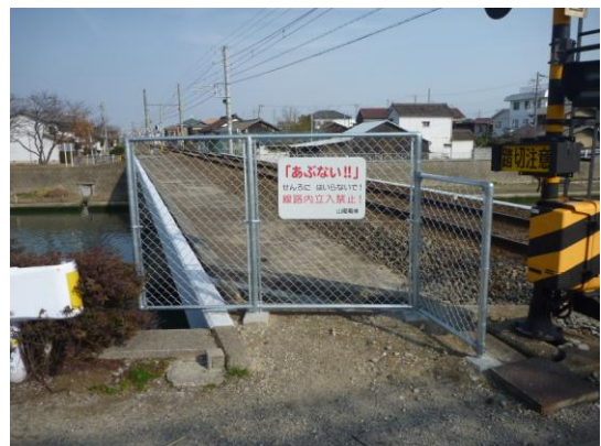
更新した立入防止柵と注意看板
