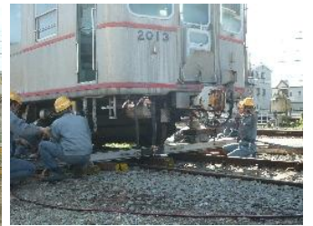
車両復旧作業
