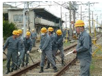
線路復旧作業
