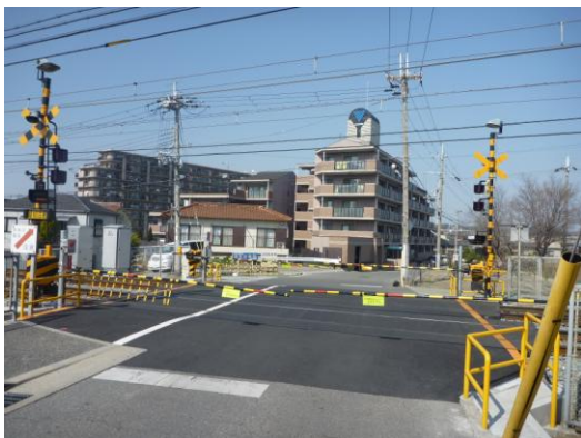
歩道部分を拡幅した柳井踏切道
