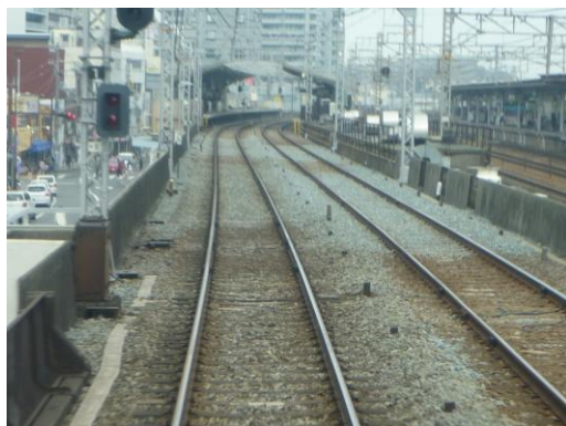
垂水駅西方道床交換
