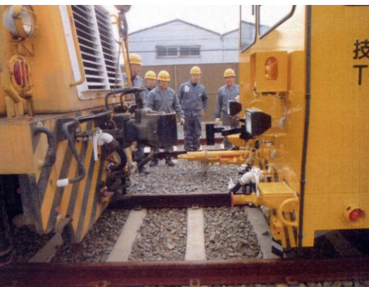
保守用機械の非常時の取扱い訓練
