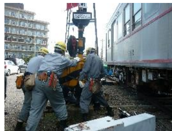
遮断機復旧作業
