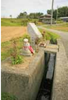
コンクリートの 水路
