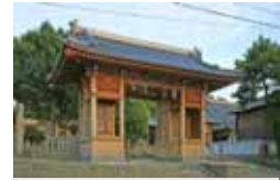
室津八幡神社（門）
