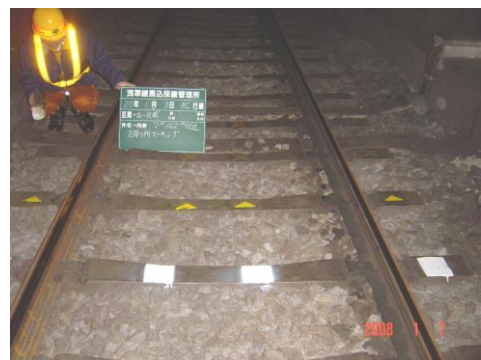
写真2 まくらぎ表示対策後
