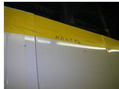
写真2 仮囲い頂部テープの 取り外し状況・再貼付け状況
