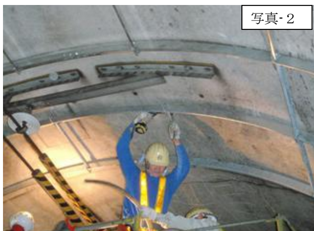
写真2 金具取り付け風景
