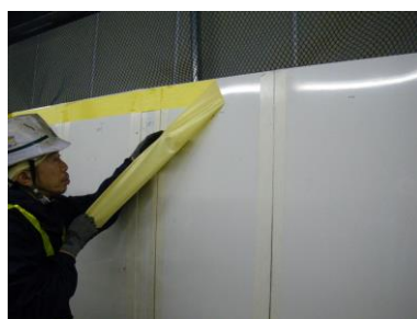
写真2 仮囲い頂部テープの 取り外し状況・再貼付け状況
