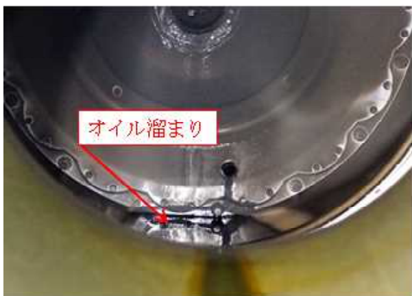
第2エンジン テールパイプ内部
