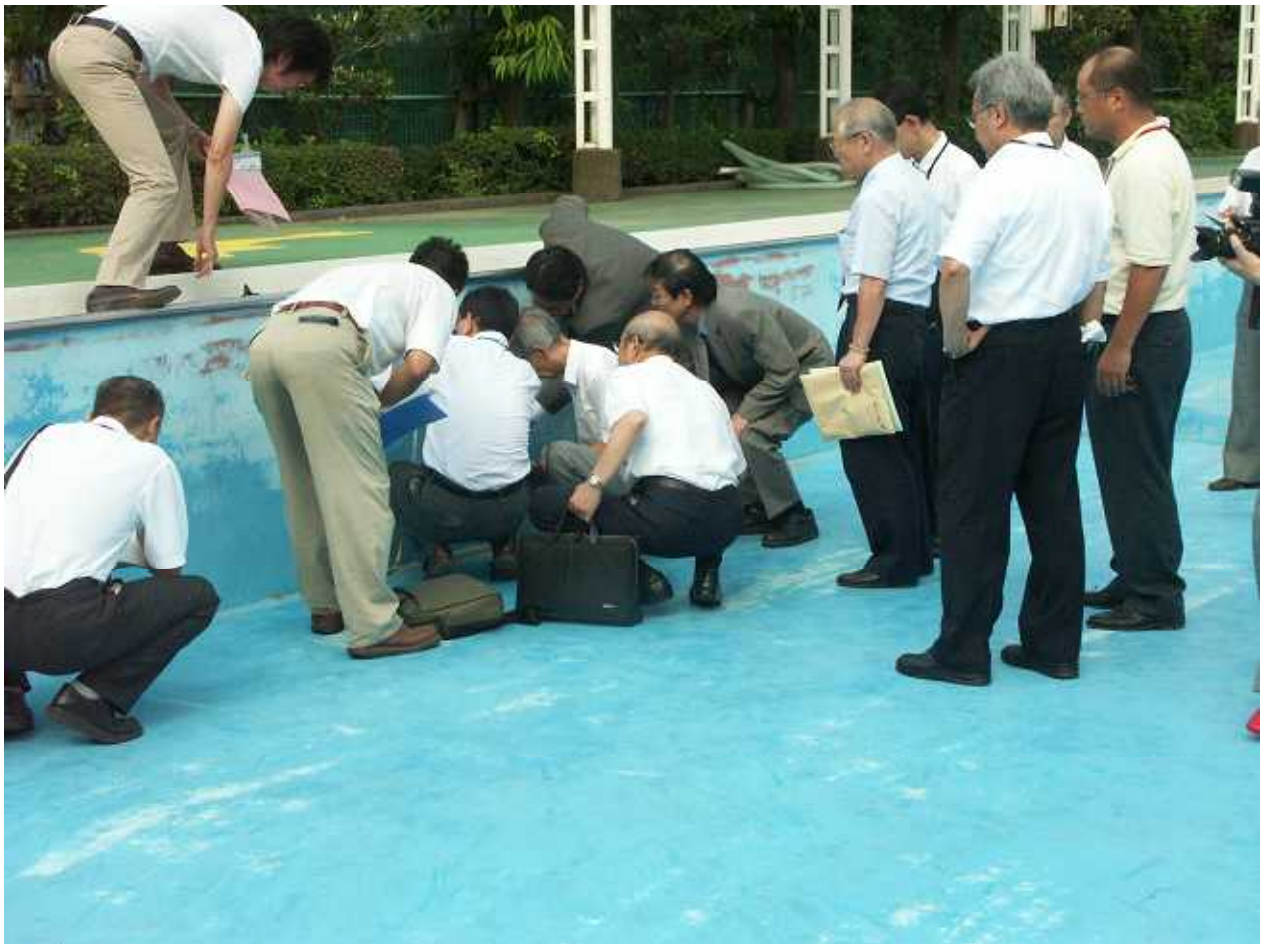
写真 大井プール施設での確認【場所：流水プール・吸水口前】
