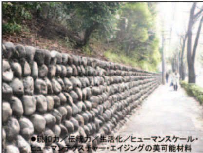
写真 16 地域らしさを感じさせる 多摩川ゴロタによる石積
