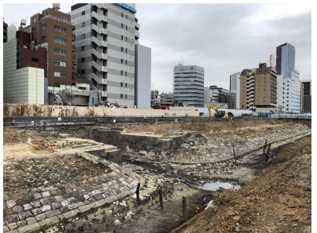
写真2 4か所に水路のための橋脚が作られています。
