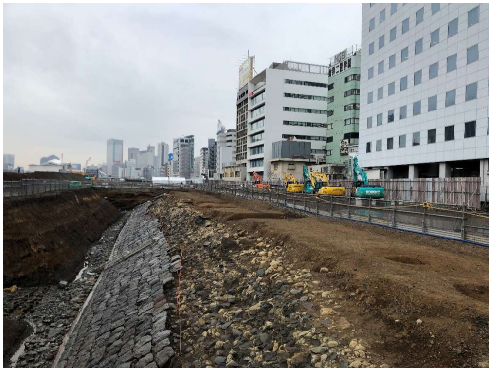
写真1 海側の石垣。写真右側築堤の上にはバラストが残されています。
