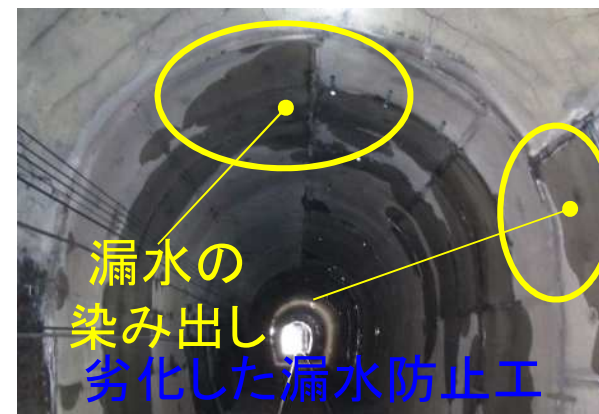
(例: 函館線 熱郭・目名間 第2白井川トンネル)
