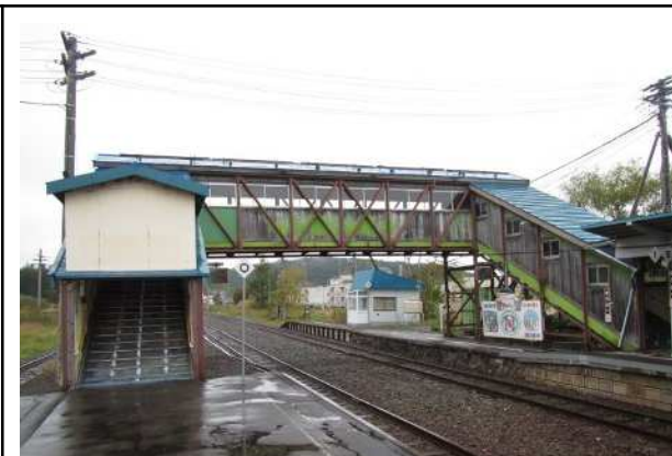
軟弱地盤上の乗換跨線橋
