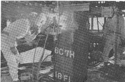
写真-2 現場施工状況
