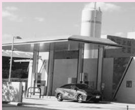
イワタニ水素ステーション 山口周南
