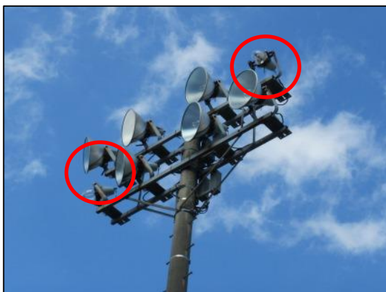
写真8 照明の破損
