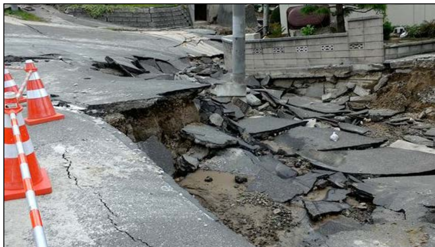
写真19 道路の陥没
