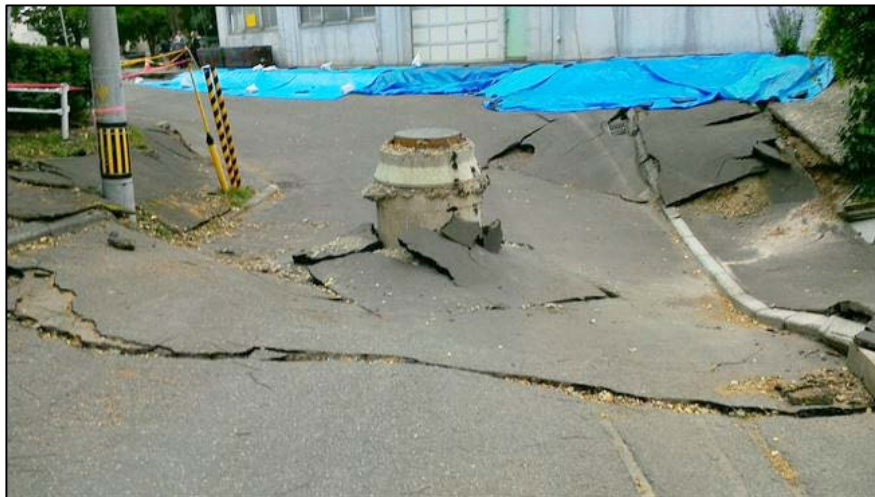
写真18 地盤沈下
