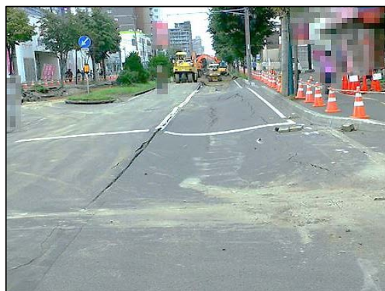
写真17 道路の沈下
