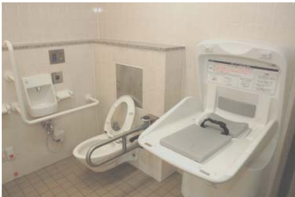
新しく設置された多機能トイレ
