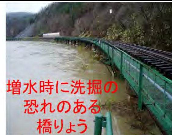
(例: 宗谷線 糠南・雄信内間 問平陸橋)
