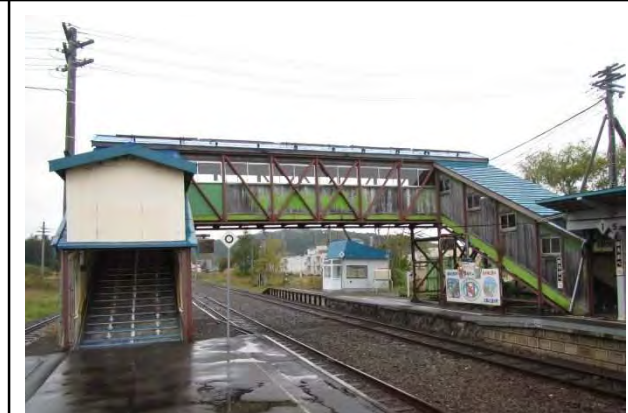
軟弱地盤上の乗換跨線橋
