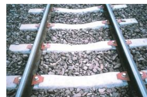
レールテック社製 レール締結装置
