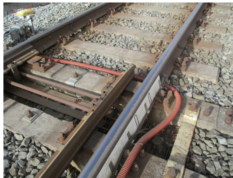
SAN Electro Heat社/デンマーク 分岐器用融雪装置
