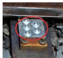
フォスロー社製 ボールベアリング床板
