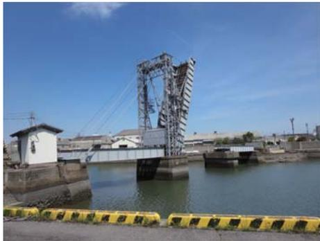
1931(昭和6)年12月に完成した「末広橋梁」は、三重県四日市市にある跳開(ちょうかい)式鉄道可動橋で、四日市港修築工事による第一号埋立地(末広町)と第二号埋立地(千歳町)間の千歳運河に架けられている。本橋梁は5つの桁によって構成される鋼製鉄道橋(単線)で、岸よりの桁が上路プレートガーダー(鋼板や鉄骨等をI字型の断面になるように組み合わせた桁)、岸から2つ目の桁が下路式プレートガーダーとなっている。可動桁の支点は四日市駅側にある。設計・製作は山本卯太郎(山本工務所)が行った。今日まで主にセメントの搬出に用いられてきたほか、中部国際空港建設時には埋め立て用土砂運搬の貨車も数多く通過している。現在(2015年)、JR
