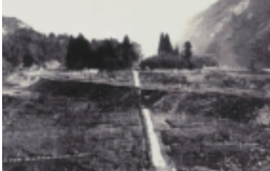
断層のずれにより、写真中央の道路が寸断している(当時撮影)(本巣市) 写真撮影:小藤文次郎氏
