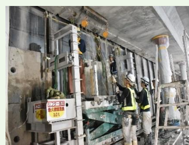
トンネルの壁を撤去する作業
