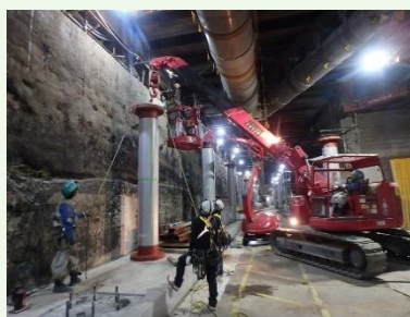
ホーム柱を設置する作業
