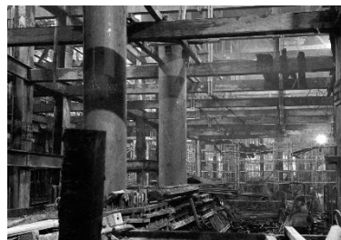
工事中の銀座駅
