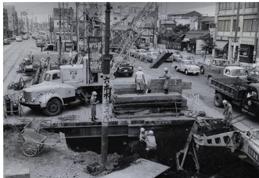
六本木付近での工事の様子
