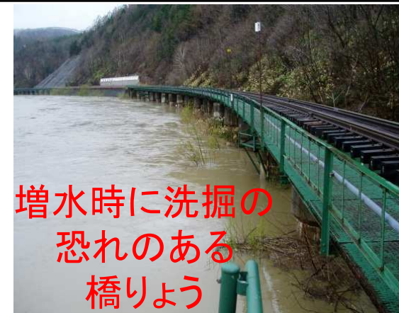
(例: 宗谷線 糠南・雄信内間 問平陸橋)
