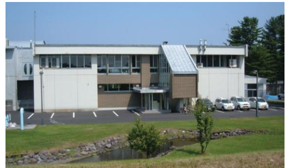
稲田浄水場（帯広市稲田町）
