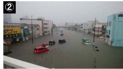
②令和2年7月豪雨 国道208号 道路冠水状況(大牟田市)
