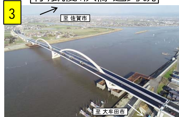
有明筑後川大橋 進捗状況
