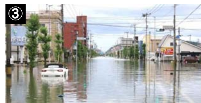
③令和2年7月豪雨 国道389号 道路冠水状況(大牟田市) ※令和2年7月豪雨写真：大牟田市HP(「大牟田市令和2年7月豪雨災害検証委員会(第1回)」会議資料より)
