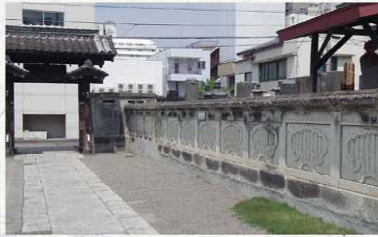
「宇都宮駅南東地区」に近い林松寺の大谷石塀
