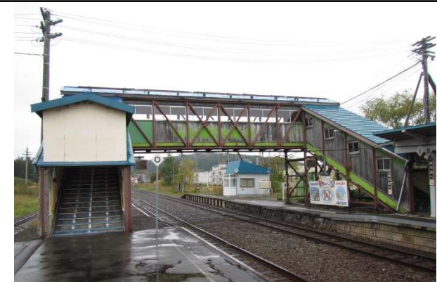
軟弱地盤上の乗換跨線橋
