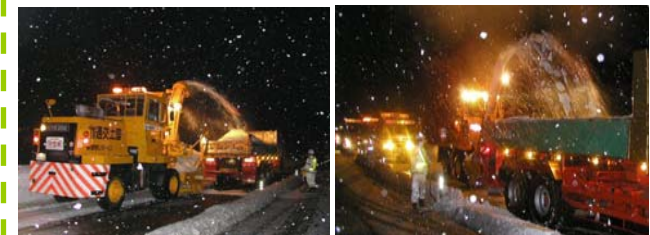
青谷・羽合道路除雪状況 H17年12月13日
