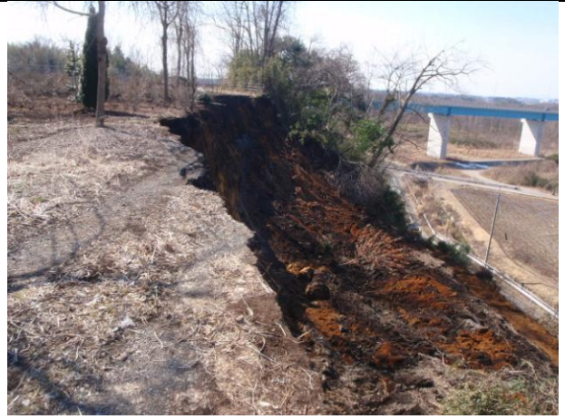
斜面崩壊頂部
