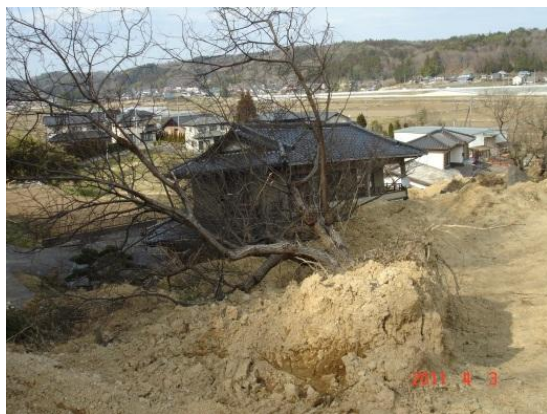
法先部付近の家屋の被害状況
