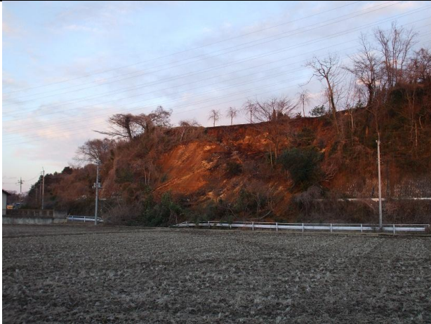
斜面崩壊遠景その 1
