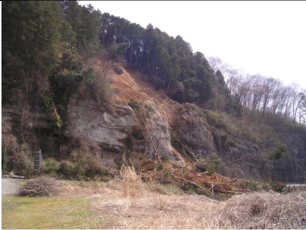
斜面崩壊遠景
