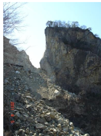
尾根部が V 字型に崩壊した岩船山 (北西側から臨む)
