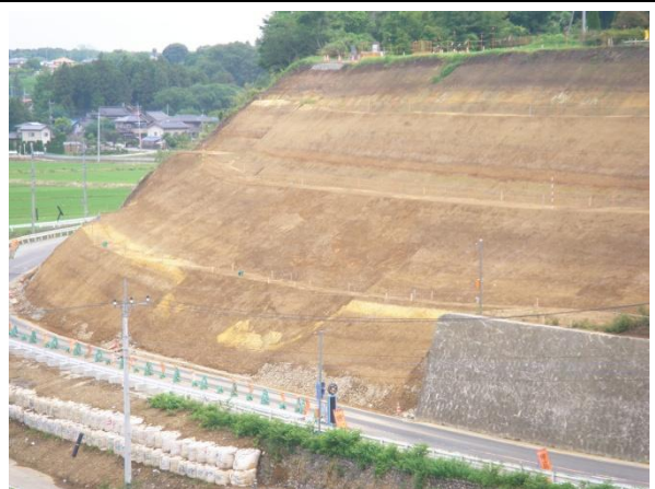
斜面復旧状況と旧斜面崩壊跡
