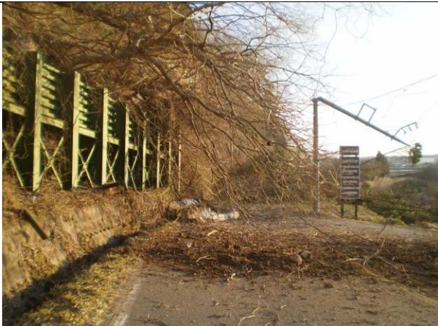
小口黒羽線の落石防護壁
