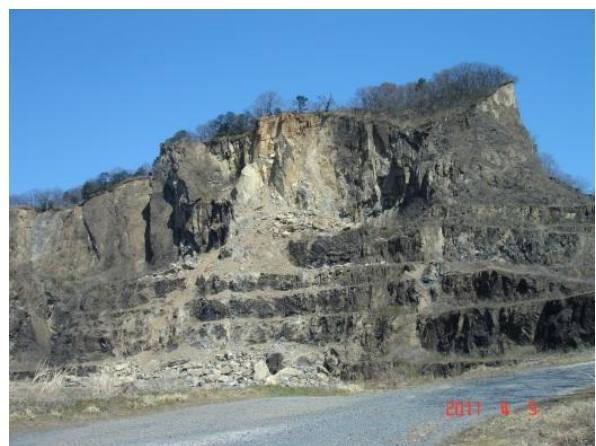
岩船山の岩盤崖部の崩壊 (南東から臨む)
