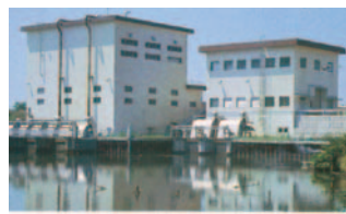
立田排水機場
