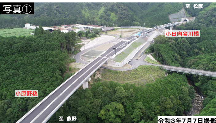
改良・付属物工事が進む小原野地区
