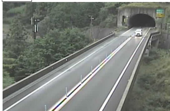
安定した走行が可能な高速道路
