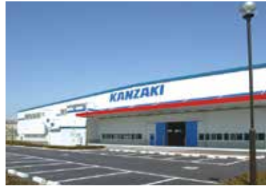
神崎高級工機の本社新工場竣工(2004.4)
