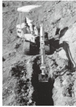
ミニバックホーによる掘削作業
