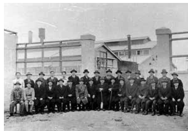
山岡内燃機前で鑄造工場完成の記念写真(1936.1.9)
