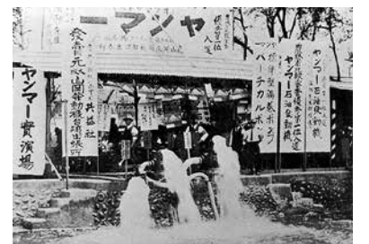
実演場で稼働するバーチカルポンプ
