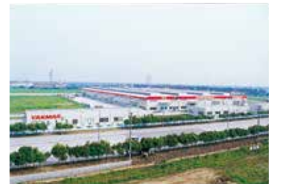
洋馬農機(中国)の工場竣工
