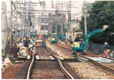
復旧現場で活躍するヤンマーVIO
