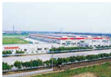
洋馬農機(中国)の工場竣工(1999.8)
