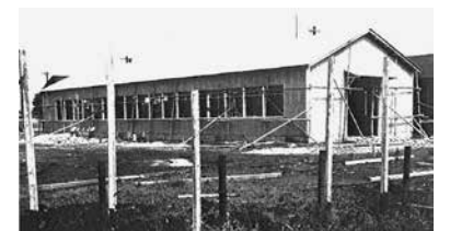
神崎高級工機の本社増築工事(1956ごろ)
