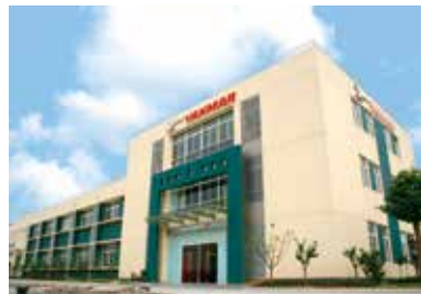
YSHのテクニカルセンター竣工(2008.6)
