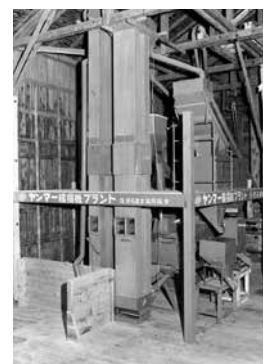
ヤンマー籾すりプラント第1号 (青森県 浅瀬石農協 1964)
