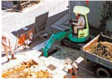
ViO15による掘削作業
