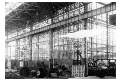
第1次整備が完了した神崎工場(1947)
