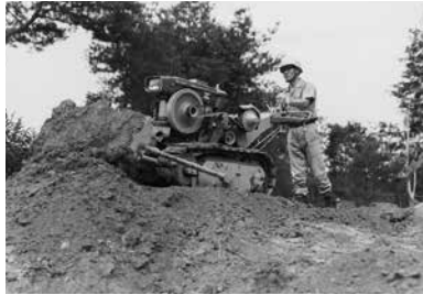
ハンドドーザによるならし作業(1966ころ)
