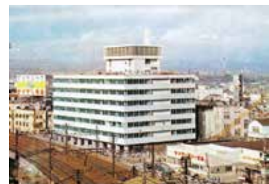
完成した本社ビル全景(1961.12)
