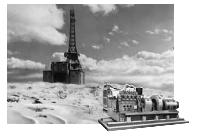
赤城山マイクロウェーブ中継所(上)に設置された無停電電源装置付ディーゼル発電装置(1954)
