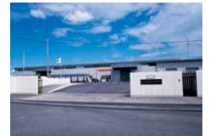
ヤンマーエネルギーシステム製造
