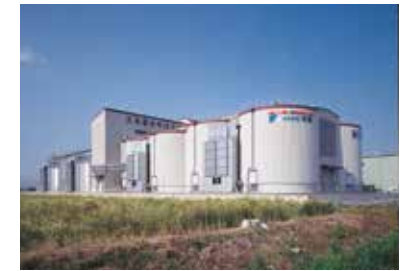
DAG(Dry Air Generator)全量貯留施設
