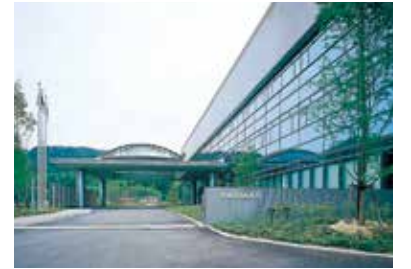
中央研究所エントランス
