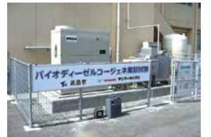
FAME100%の燃料を使用したコージェネシステムの実証試験(2006.7)
