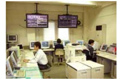
遠隔監視センター
