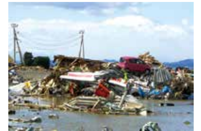
倒壊したヤンマー農機販売・仙台支店
