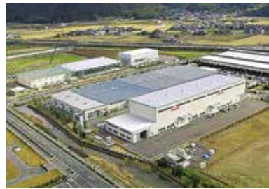
ヤンマーエネルギーシステム製造
