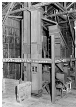
ヤンマー粃すりプラント第1号 （青森県 浅瀬石農協 1964）
