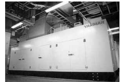
札幌駅前のJRタワー(上)と設置されたソーラーガスタービン発電装置
