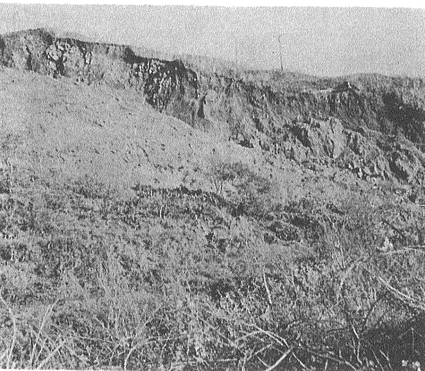
地すべり崩土 地すべり土砂が亀裂のため さらにくずれている
