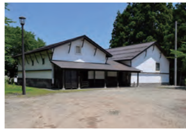
保存整備した2棟の浜倉(明治5年建築)
