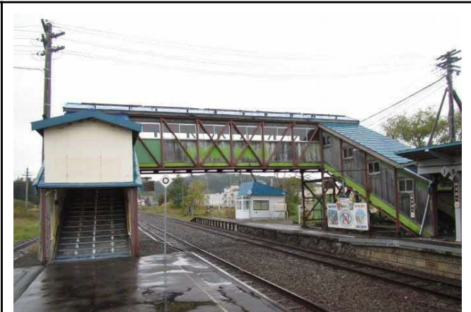
軟弱地盤上の乗換跨線橋
