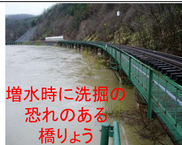
(例: 宗谷線 糠南・雄信内間 問平陸橋)
