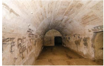
ココポ～ラバウルにかけて随所にあるトンネル群、これは第13兵站病院と思われる
