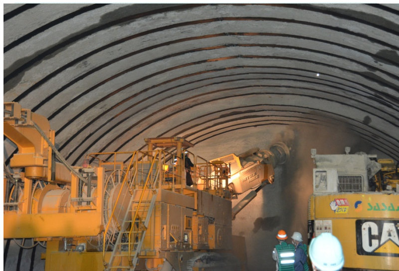
▲ 貫通掘削（掘削状況）
