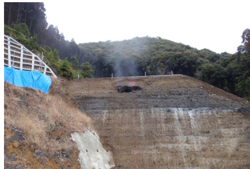
▲ 貫通した反対側坑口（宮崎県側）
