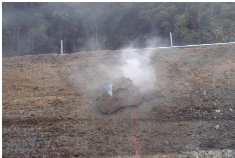
▲ 貫通した反対側坑口（宮崎県側）
