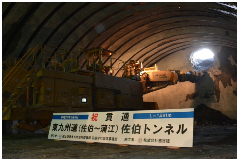
▲ 貫通掘削（掘削完了）
