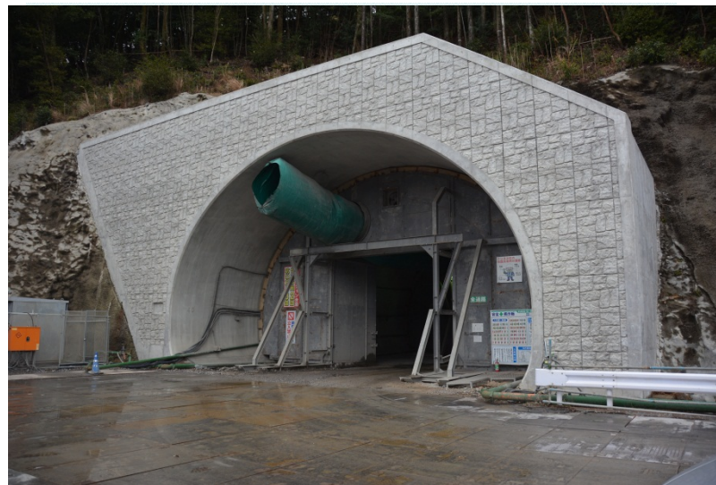
▲ トンネル坑口（北九州市側）
