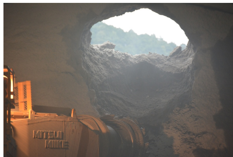
▲ 貫通掘削（掘削完了）
