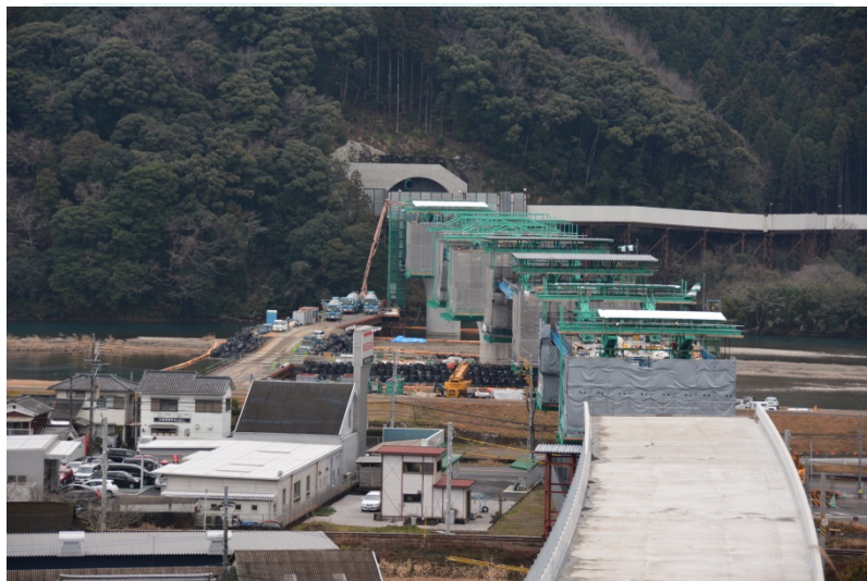
▲ トンネル坑口（北九州市側）
