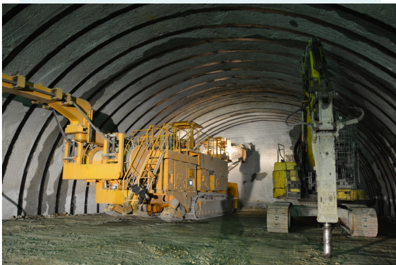
▲ 貫通掘削（掘削直前）
