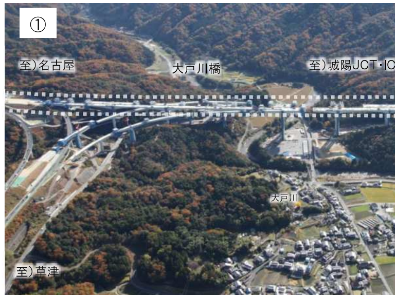
大戸川橋の整備状況 (2023年11月撮影)
