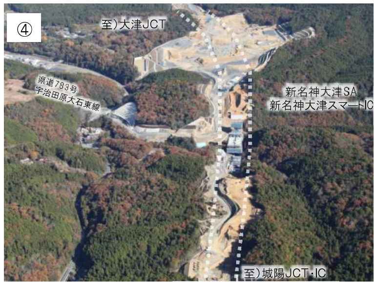
山間部(大石地区)の整備状況 (2023年11月撮影)
