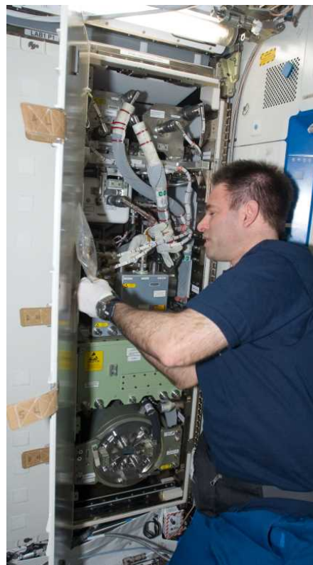
図4.2-2 米国の酸素生成装置(OGS)(NASA)
