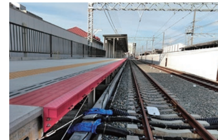
堺市内連続立体交差事業(浜寺公園駅部)
