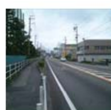
車道(歩道あり)
