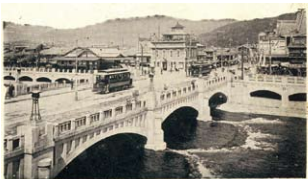
三条大橋の林立する橋脚（上）と四条大橋のアーチ（下）。京阪電車のホームを支える構造は橋のデザインと呼応している 「土木学会図書館 戦前土木絵葉書ライブラリー」
