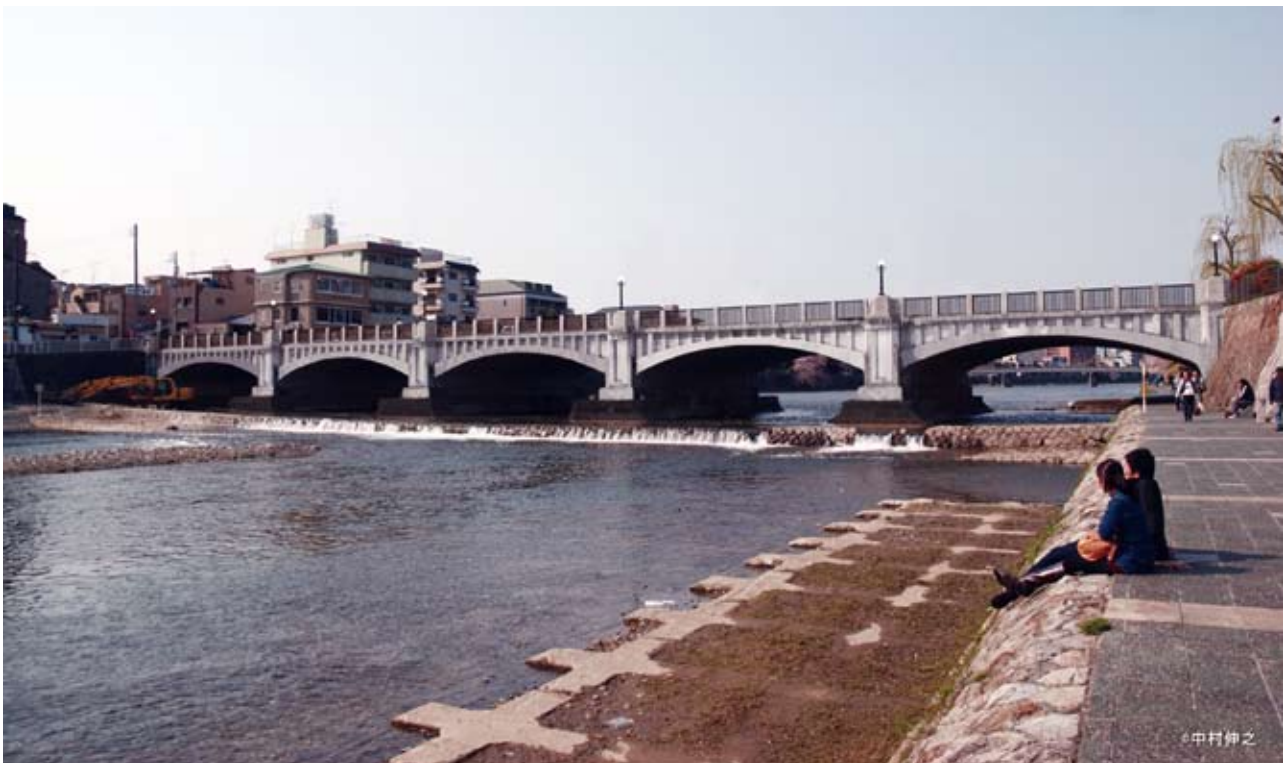
七条大橋を竣工当時の姿に復元するシミュレーション写真をつくった。黒ずんで汚れた側壁をクリーニングし、高欄と照明柱を当時の姿に戻すことで明治の意匠がよみがえり、鴨川に新たな名所が生まれるだろう。
